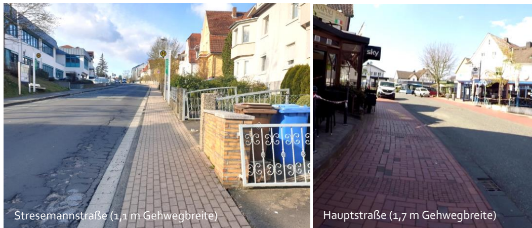
Abbildung 14: Beispielhafte Mängel zu Gehwegen und Breiten
