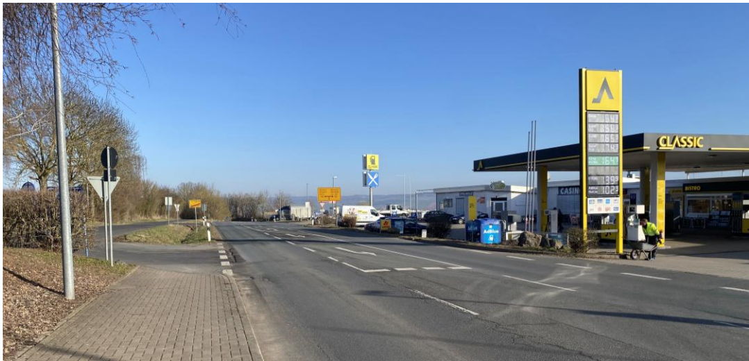
Abbildung 4: Blick entlang der Giflitzer Straße in Richtung Norden
