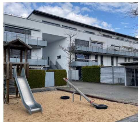
Aufstockung von Bestandsgebäuden (oben) und Spielanlagen im Wohngebiet (unten)
