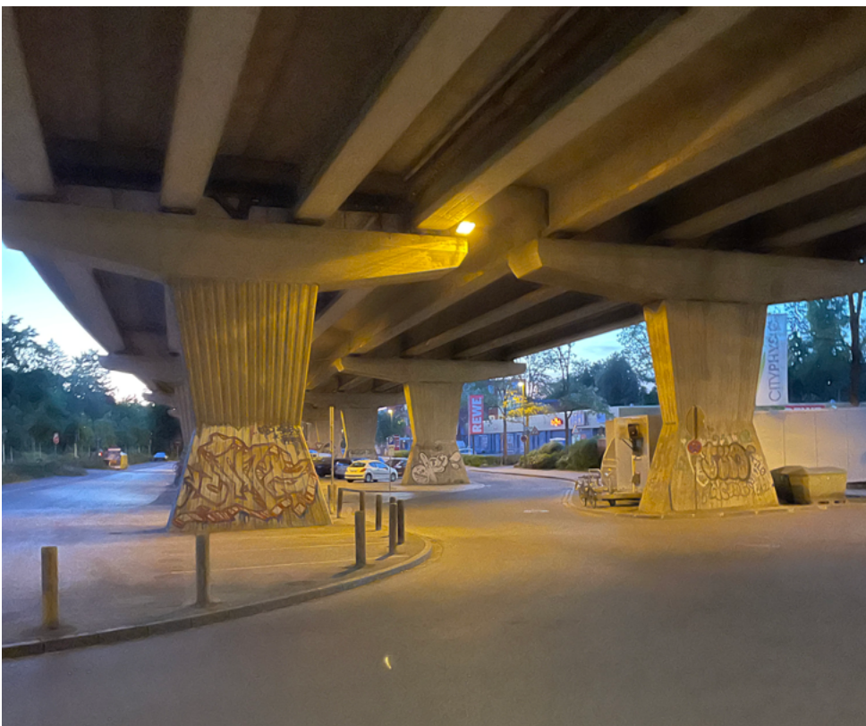
Resträume unter der Autobahn
