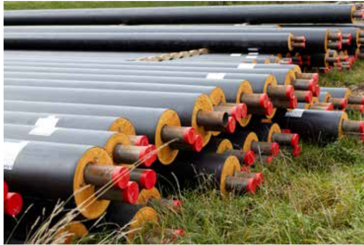
Diese unterirdischen Rohrleitungen transportieren die in der Heizzentrale erzeugte Wärme direkt in die einzelnen Haushalte.
