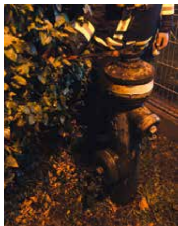
Eine angrenzende Hecke verhindert ein schnelles Öffnen des Hydranten
