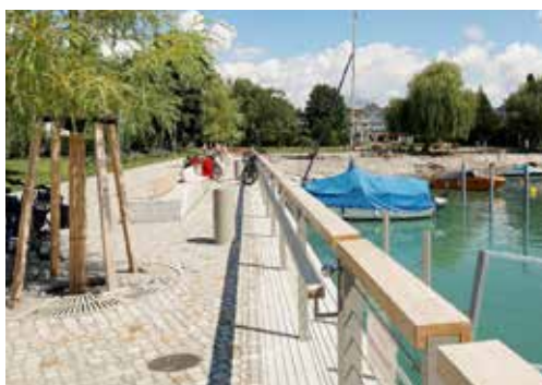
Die neue Ufermauer zielt das Hafenbecken im Bauabschnitt 1
