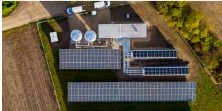
Das Bild zeigt die Großwärmepumpe in Mertingen. Diese gewinnt Wärme aus der Umgebungstemperatur und speist sie in das lokale Wärmenetz.
