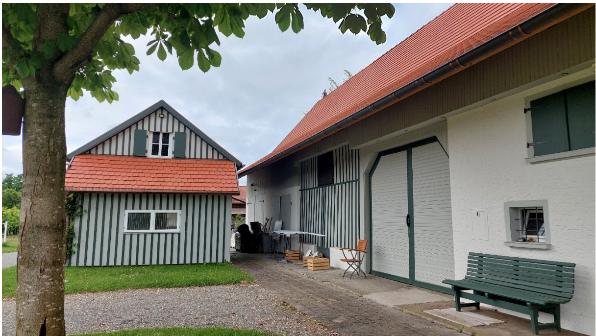
Abb. 6: Hofstelle Schwand Nr.1 von Norden.
